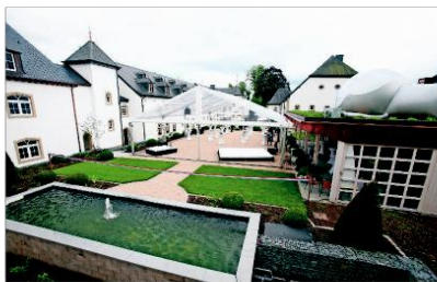
Blick in den neuen Innenhof mit Sonnendach.
